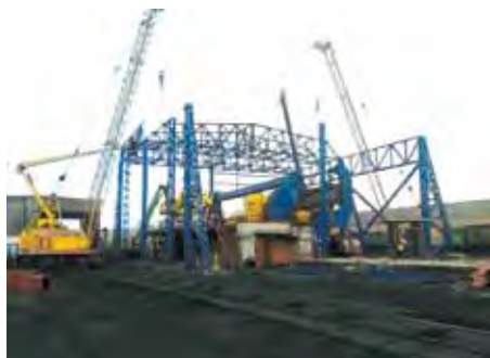
Виготовлення і монтаж металоконструкцій будівель
