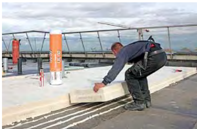
Влаштування теплоізоляційного шару клейовим способом з використанням теплоізоляційних плит Баудер ПІР МФ
