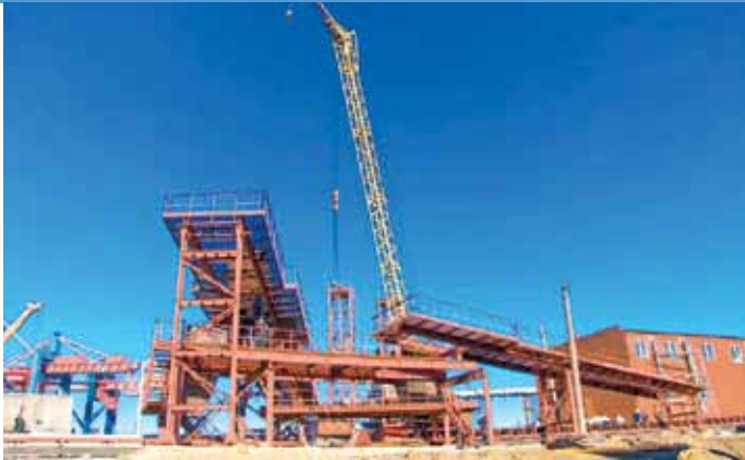
Виготовлення і монтаж металоконструкцій конвеєрних галерей
