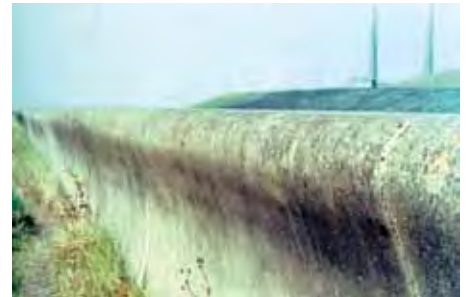
б) бар'єрна стінка від морської води з бетону на основі композиційного цементу з використанням золи видалення забезпечує корозійну стійкість більш ніж на 30 років експлуатації
