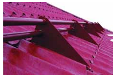
Трубчасті снігозатримувачі пропускають лід і сніг між трубками порційно. Використовуються на покрівлях з металочерепиці, профнастилу, фальцевій, бітумній та інших. Стандартна довжина труб – три метри.
