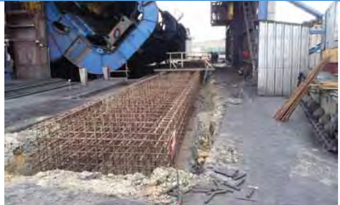
Виконання загальнобудівельних робіт
