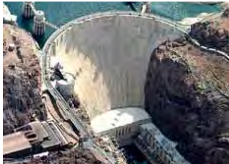
Масивне бетонування конструкцій як процес високих температурних навантажень на структуру бетону при гідратації цементів, наприклад, при будівництві гідроелектростанцій
