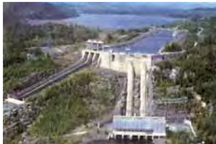
в) The Lower Notch Generating Station побудована з використанням мінеральних добавок, які забезпечили блокування впливу агресивного середовища з одночасним зниженням деструктивних явищ конструкції, що підвищило термін експлуатації до більше 50 років без деструктивних явищ. Відмічена також позитивна властивість самозаліковувати відкриті тріщини конструкції в процесі експлуатації у жорстких умовах середовища
