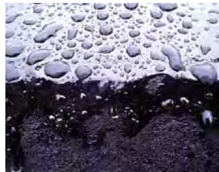
Гідроізоляційні мастики повністю блокують просочування вологи в пори покрівельного матеріалу
