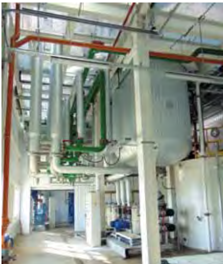
Реактор приготування карбамідоформальдегідної смоли
