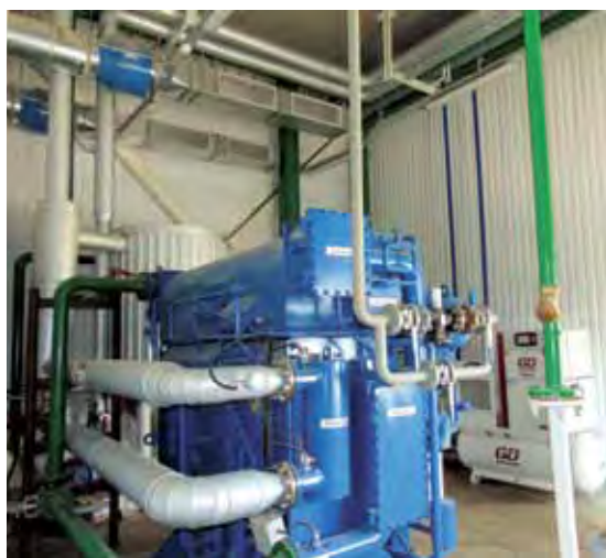
Абсорбційний чиллер (система охолодження рідини)
