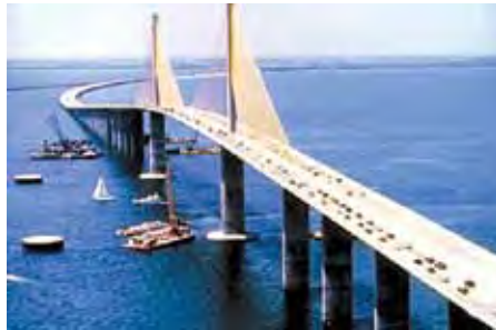
а) міст Саншайн-Скайуей ім. Боба Грема побудований з використанням золи видалення та металургійного шлаку в складі портландцементу для надання надійного захисту від агресивного середовища
