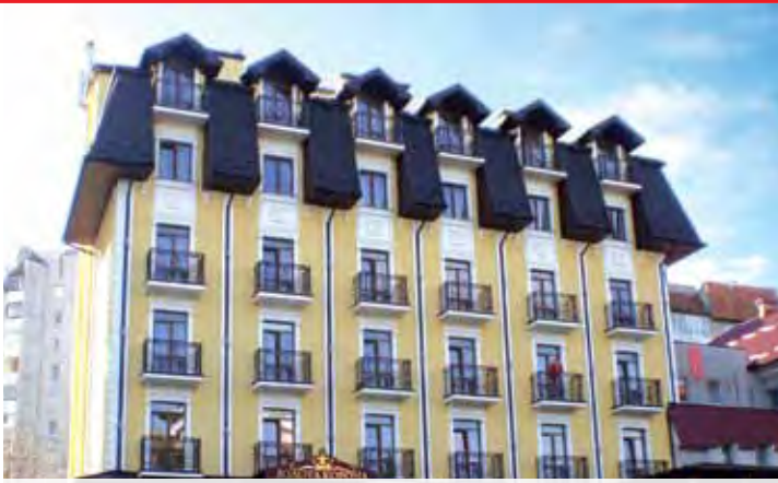
Для утеплення готелю «Львів» застосовано пінополістирольну систему з акриловою штукатуркою «баранек» і мозаїчною штукатуркою з кварцевого піску
