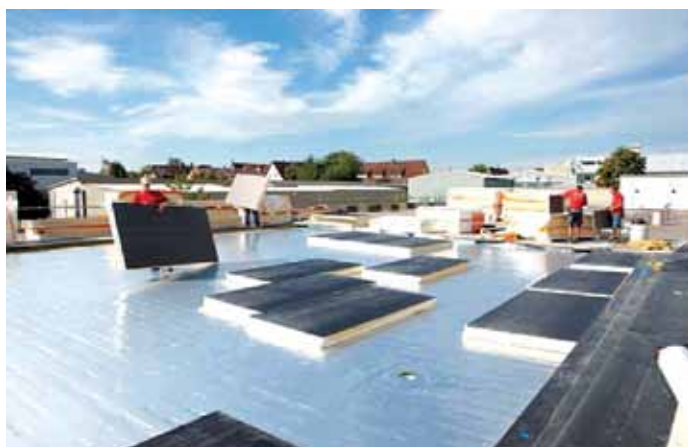
Влаштування теплоізоляційного шару механічним способом з використанням теплоізоляційних плит Баудер ПІР ФА
