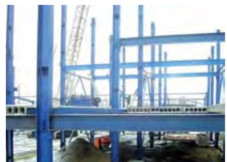
Зведення промислових будівель і споруд
