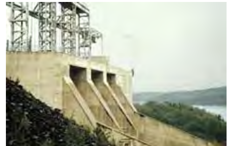
в) The Lower Notch Generating Station побудована з використанням мінеральних добавок, які забезпечили блокування впливу агресивного середовища з одночасним зниженням деструктивних явищ конструкції, що підвищило термін експлуатації до більше 50 років без деструктивних явищ. Відмічена також позитивна властивість самозаліковувати відкриті тріщини конструкції в процесі експлуатації у жорстких умовах середовища
