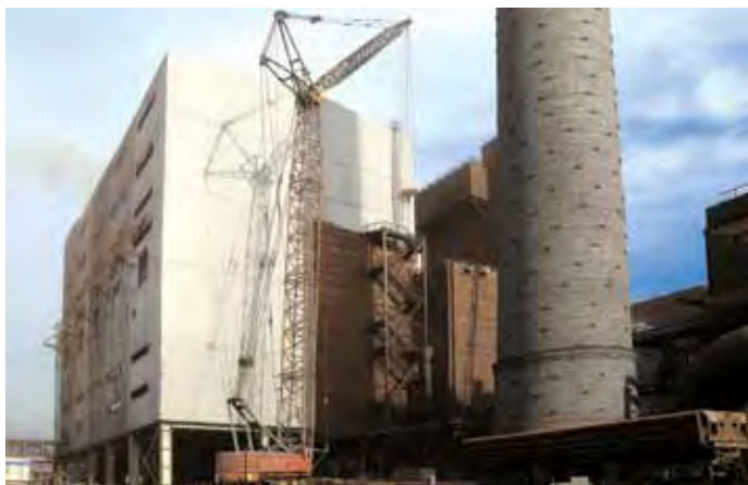
Газоочисне устаткування на аглофабриці з системою екологічного моніторингу
